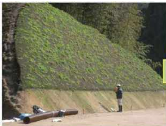
<のり面地山の状態>
